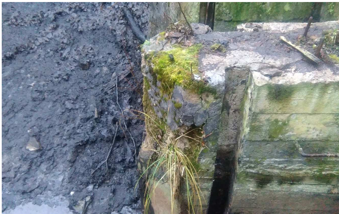
Zdjęcie nr 2: Znacznie skorodowany beton filara środkowego
