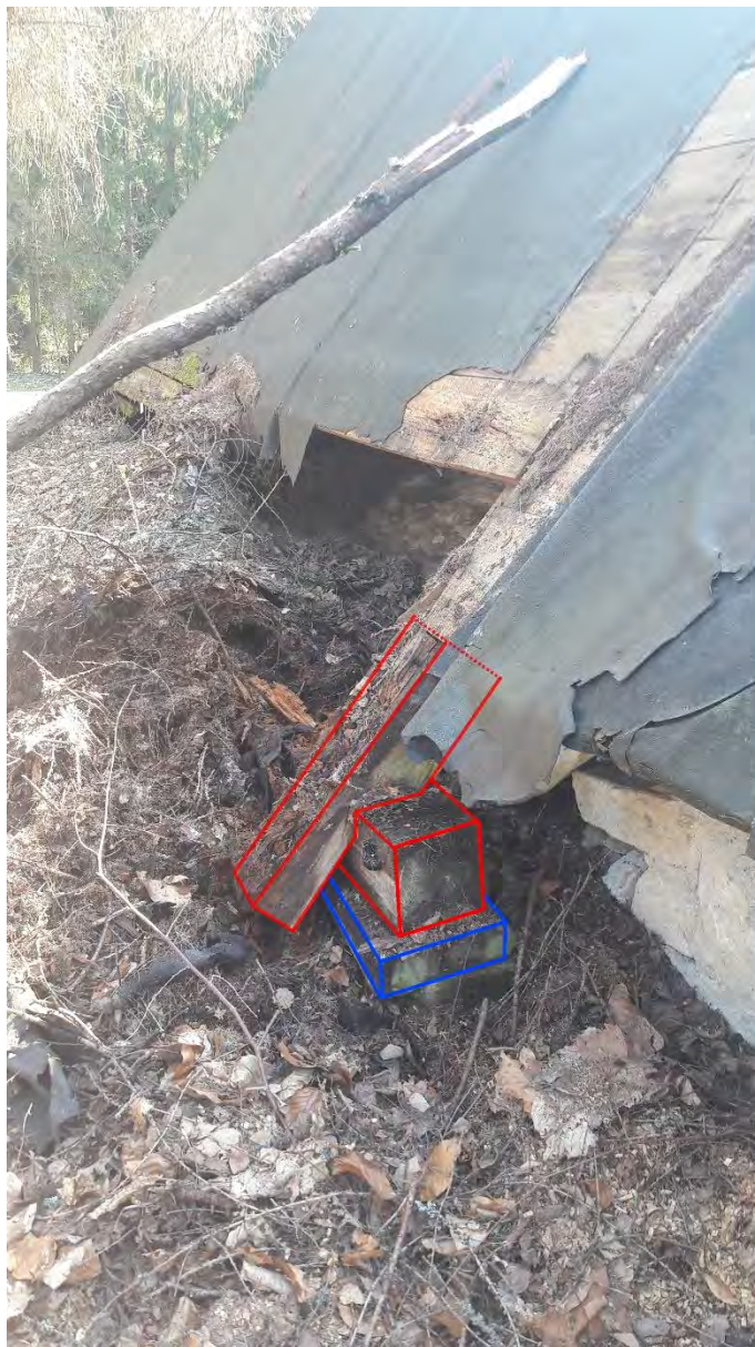
Remont zadaszenia piwnicy wolnostojącej – krokwie oparte na belce leżącej na podwalinie – stan istniejący. - Osada Cegielnia -
