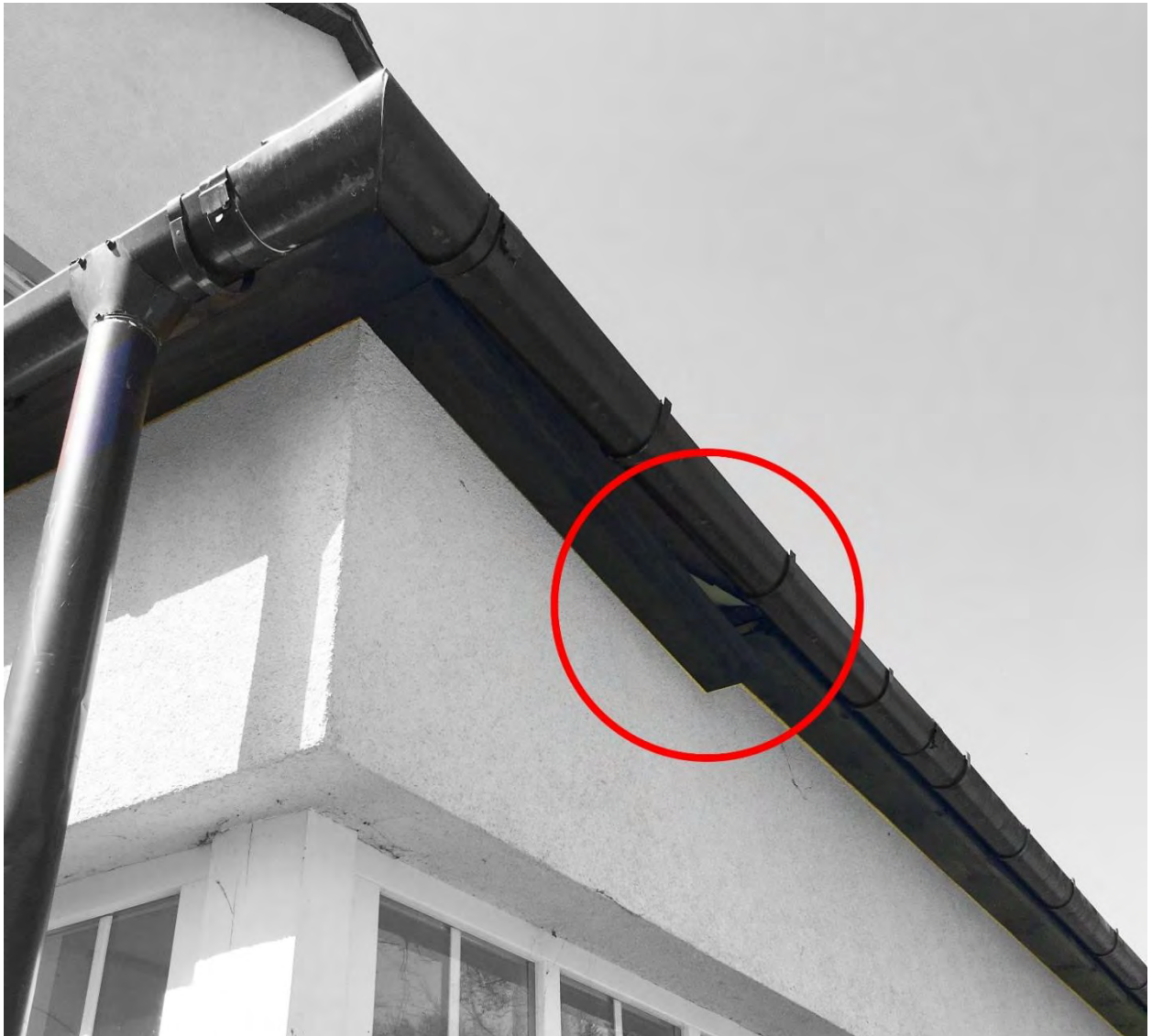
Wymiana podsufitki na budynku mieszkalno-administracyjnym. - Osada Kosobudy 100A -
