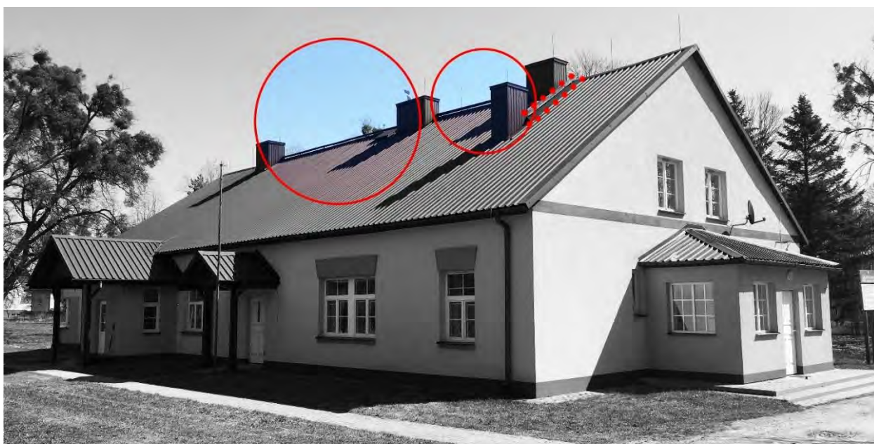
Wymiana i montaż ław i stopni kominiarskich na budynku mieszkalno-administracyjnym. - Osada Kosobudy 100A -
