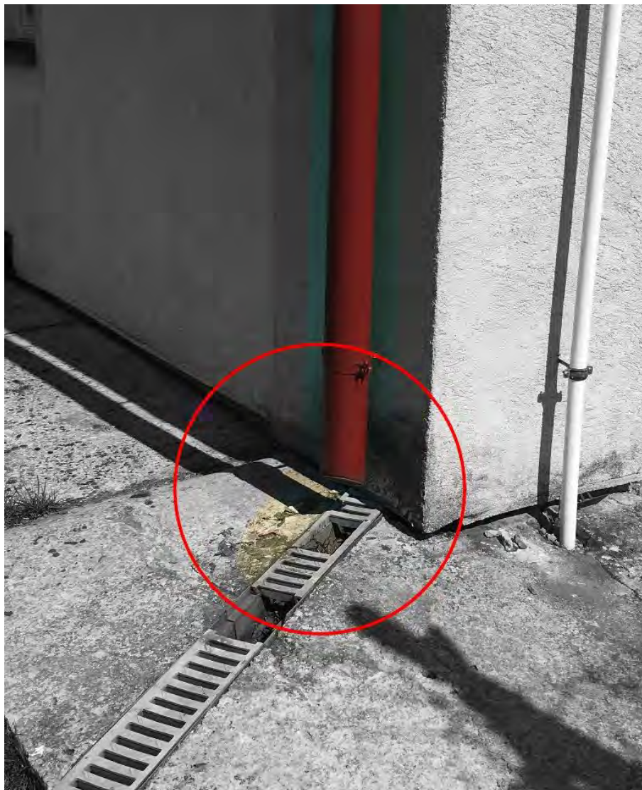
Brakująca wylewka rury spustowej na budynku mieszkalnym. - Osada Słupy – Kosobudy 62 – „Horodzisko” -
