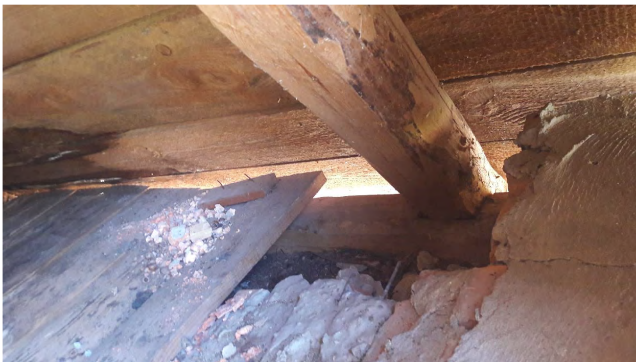
Remont zadaszenia piwnicy wolnostojącej – krokwie 01 oraz 02 oparte na murłacie. - Osada Cegielnia -
