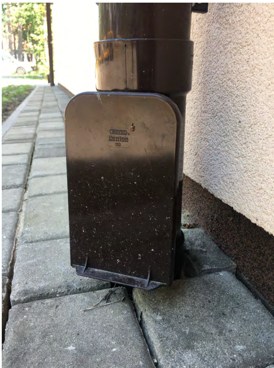
Montaż czyszczaków – rewizji na rurach spustowych – przykładowe rozwiązanie zastosowane na budynku sąsiednim.
