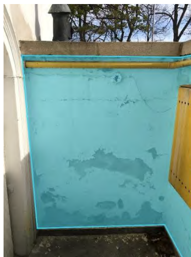
Rysunek 2. Schemat naprawy tynku przy schodach - nowa powłoka tynkarska
