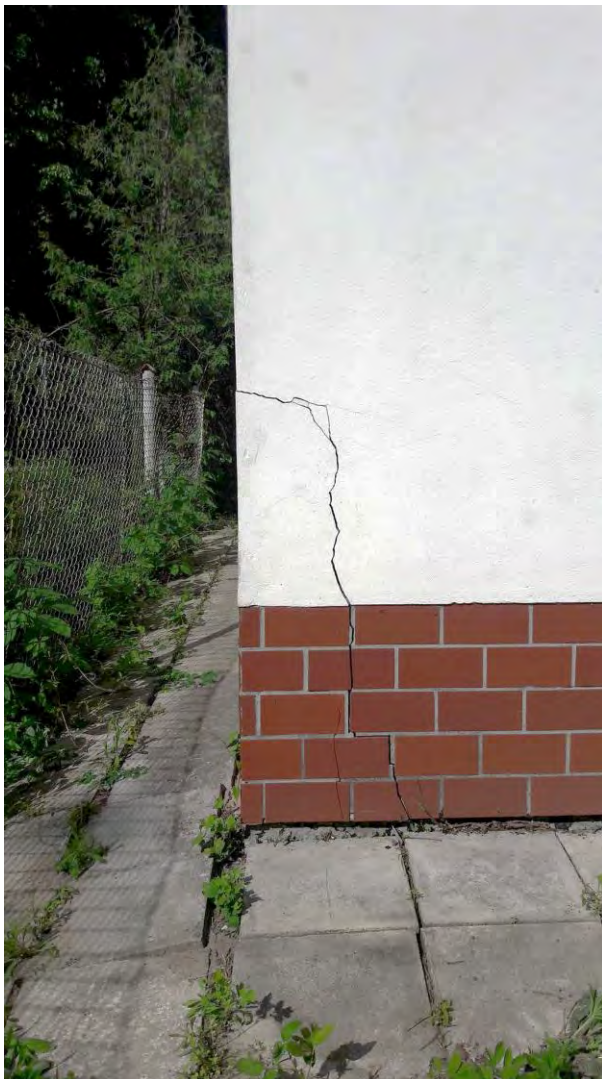
Fot. 7 Zarysowanie w południowo-zachodnim narożniku
