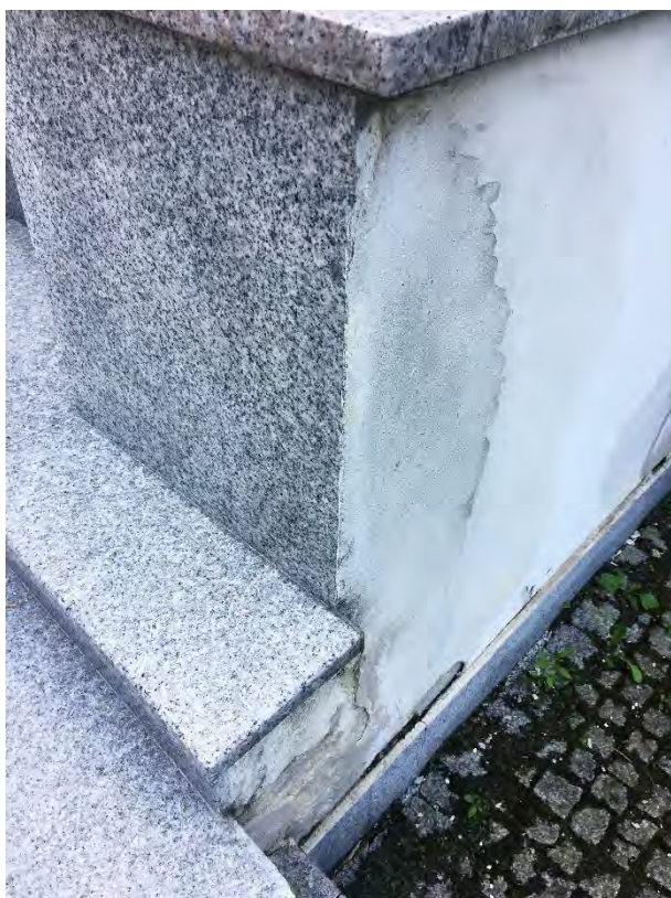
Fot. 10 Uszkodzenie tynku przy schodach wejściowych
