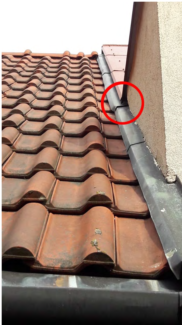
Usunięcie przecieku w pokryciu dachowym. - Ośrodek Edukacyjno-Muzealny – ul. Plażowa 3 -
