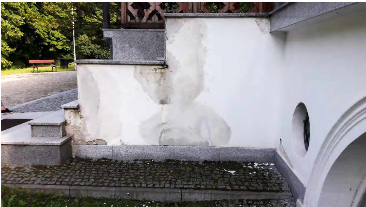
Fot. 6 Uszkodzenie tynku przy schodach wejściowych
