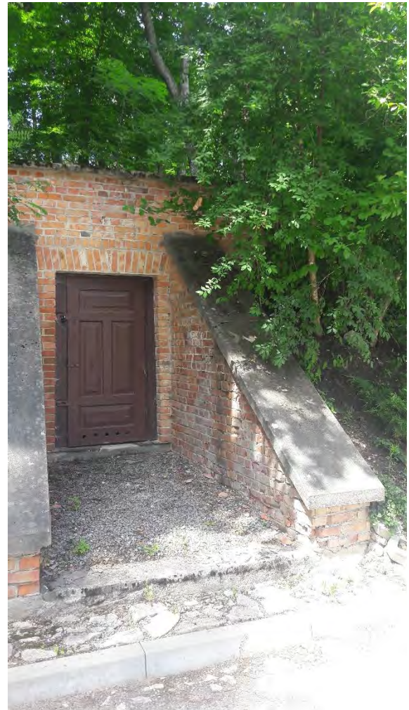
Fot. 4 Mur oporowy przy wejściu do lodowni
