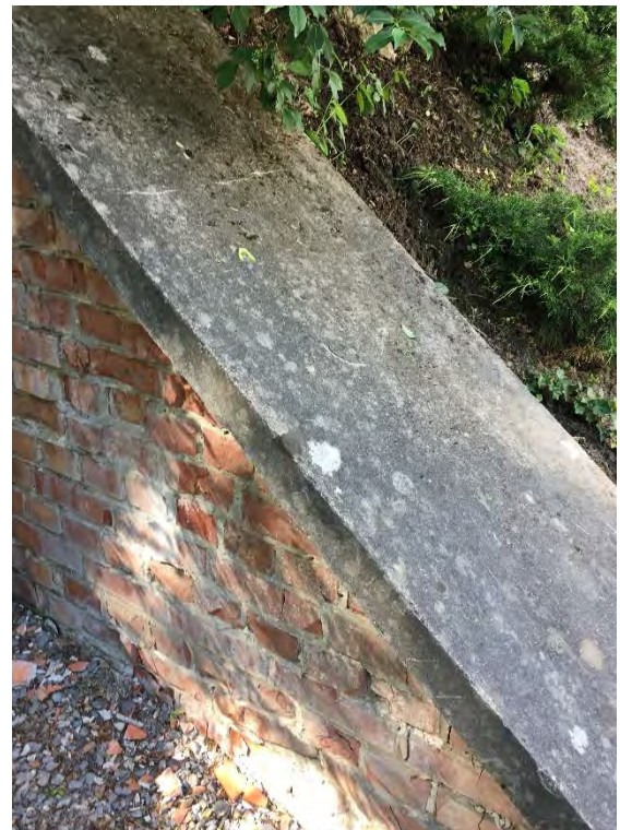
Fot. 6. Uszkodzenie muru oporowego na zewnątrz
