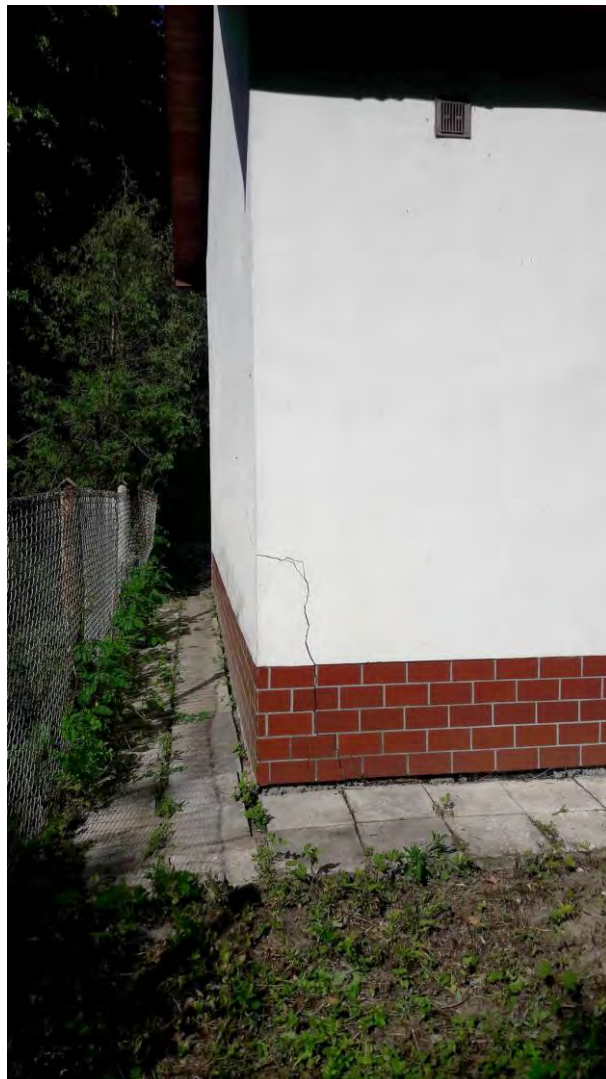
Fot. 8 Zarysowanie w południowo-zachodnim narożniku
