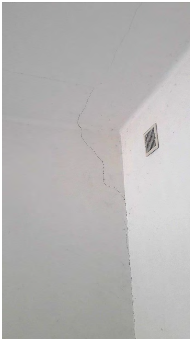
Fot. 12 Zarysowanie wewnątrz budynku
