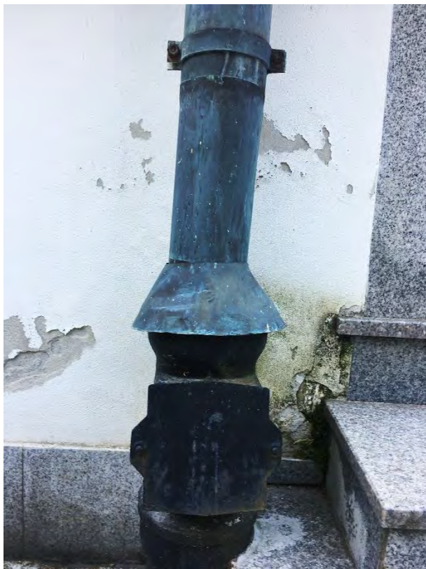
Fot. 12 Uszkodzenie tynku za rurą spustową
