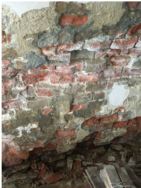
Fot. 9. Uszkodzenie ściany wewnętrznej
