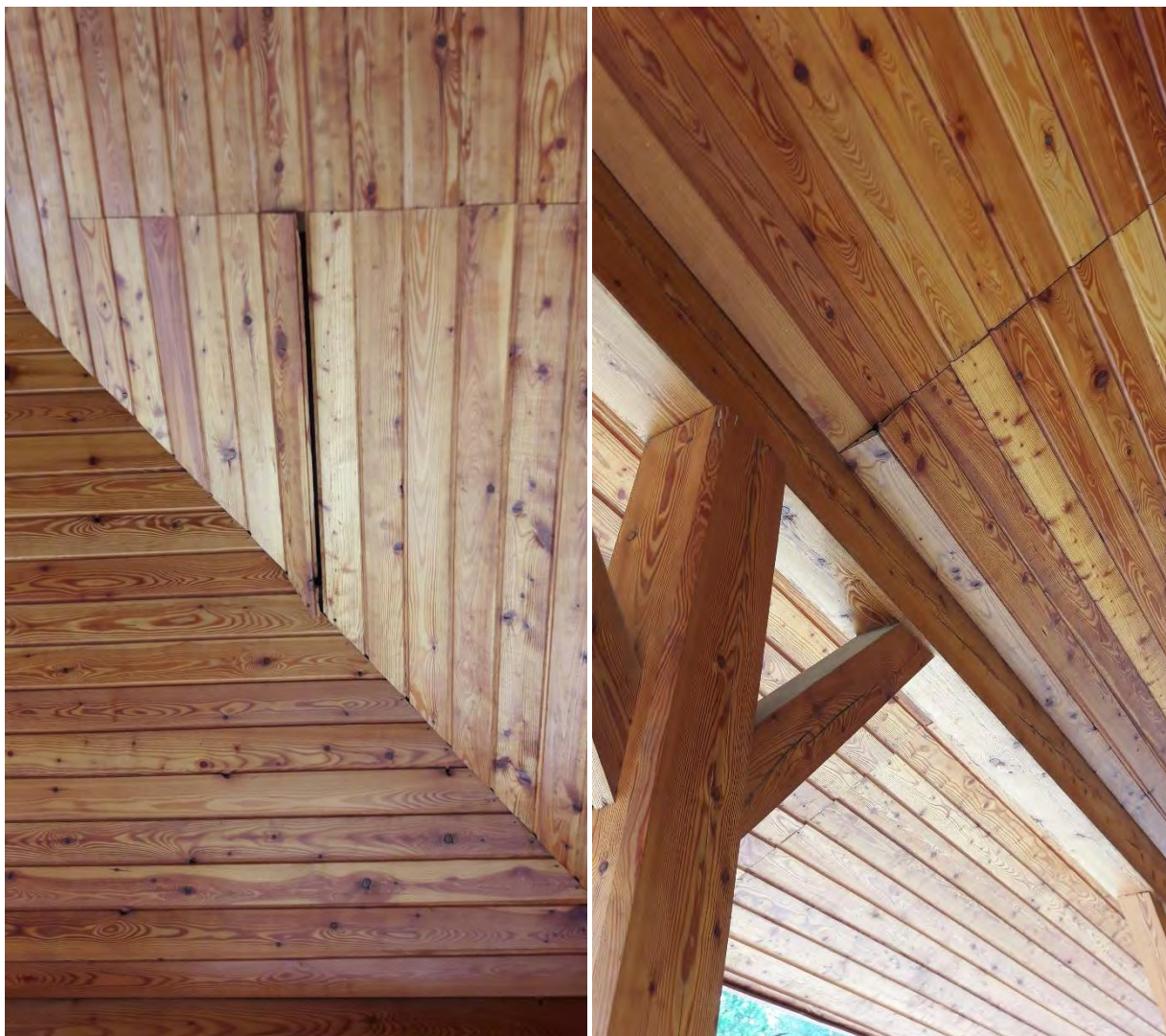
Remont desek w podsufitce. - Osada Zwierzyniec – ul. Plażowa 3 -
