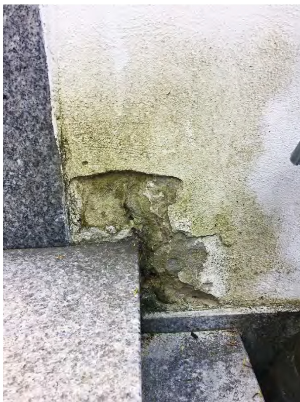
Fot. 11 Uszkodzenie tynku przy schodach wejściowych
