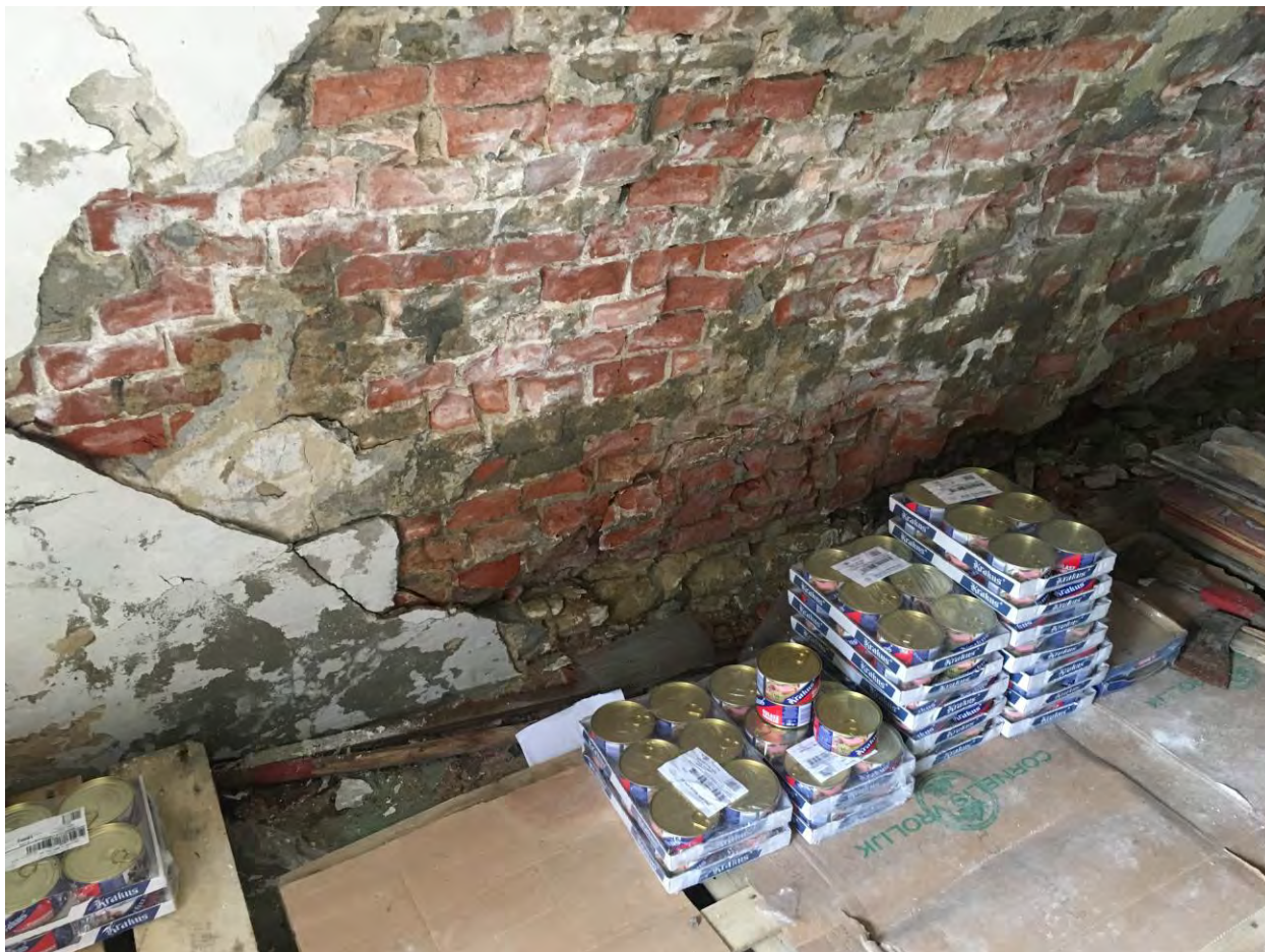
Fot. 7. Uszkodzenia lica muru po stronie wewnętrznej
