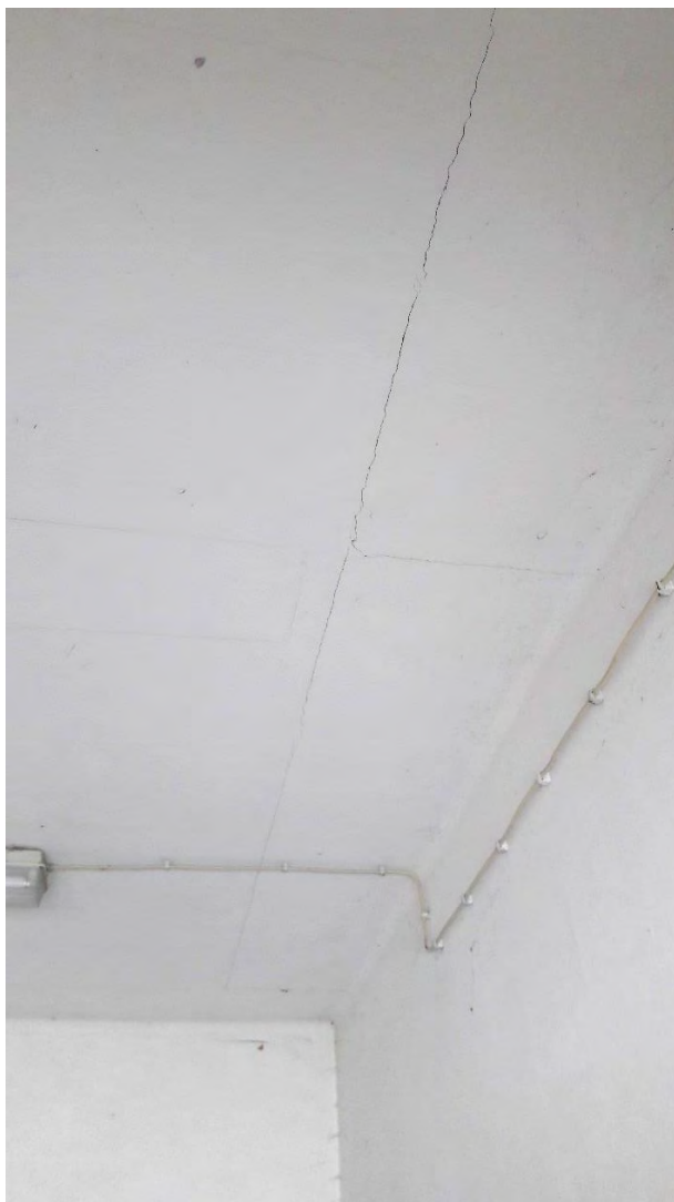
Fot. 11 Zarysowanie wewnątrz budynku
