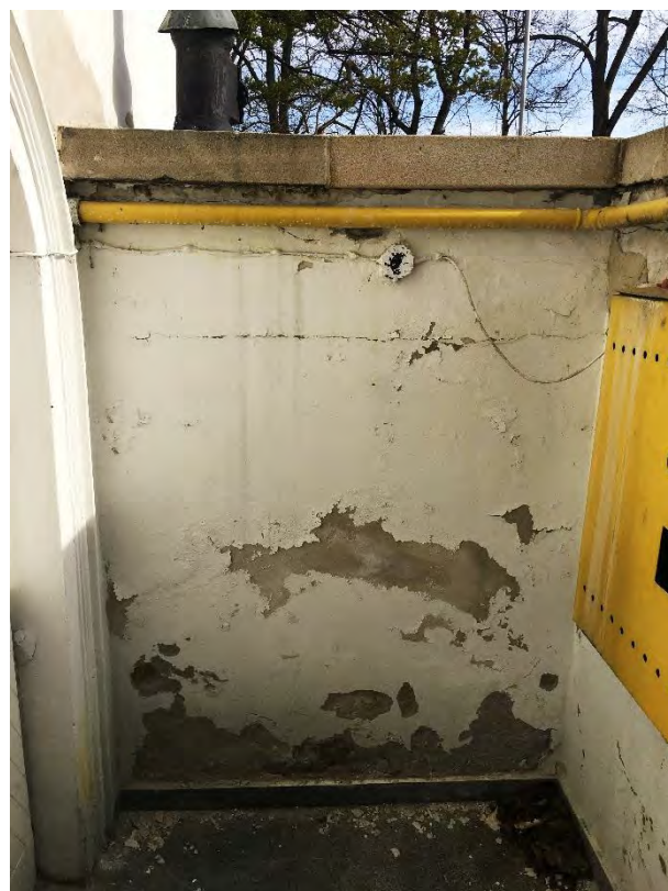
Fot. 17 Uszkodzenia muru oporowego przy schodach do piwnicy
