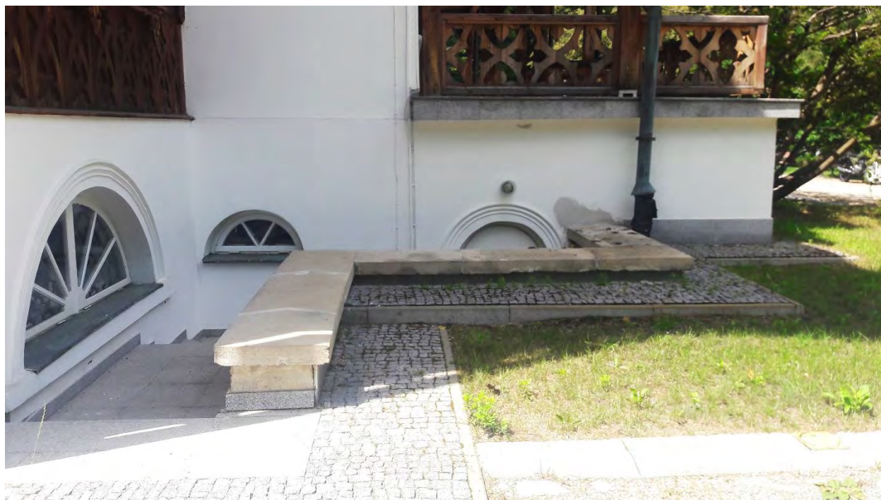
Fot. 14 Uszkodzenia cokołu i muru oporowego przy schodach do piwnicy
