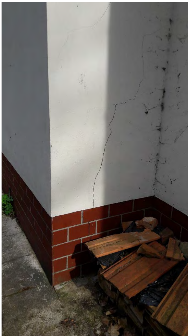
Fot. 6 Zarysowanie na południowej elewacji
