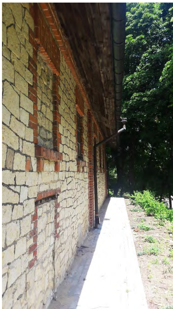
Fot. 5 Elewacja tylna - widok od strony wschodniej na szczegół ściany murowanej z opoki
