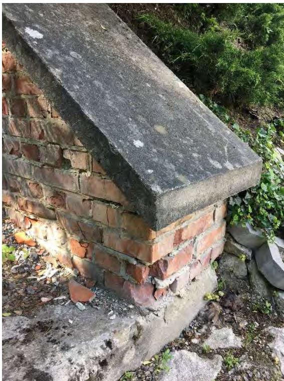
Fot. 5. Uszkodzenie muru oporowego na zewnątrz
