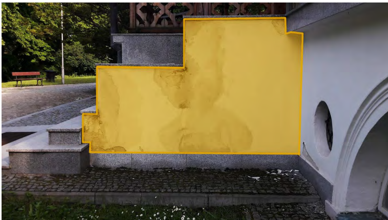
Rysunek 7. Schemat naprawy tynku przy schodach - nowa powłoka tynkarska
