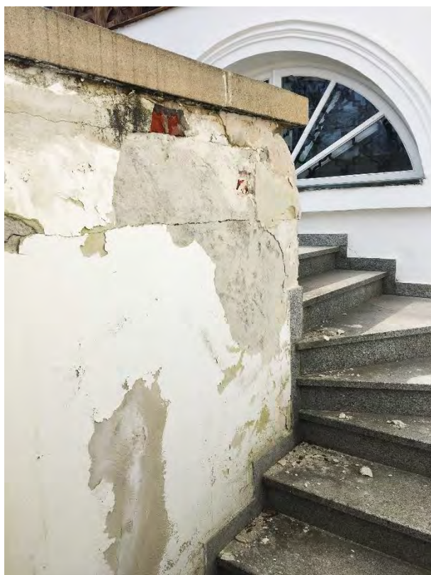
Fot. 16 Uszkodzenia muru oporowego przy schodach do piwnicy
