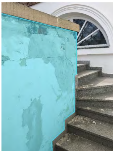
Rysunek 1. Schemat naprawy tynku przy schodach - nowa powłoka tynkarska
