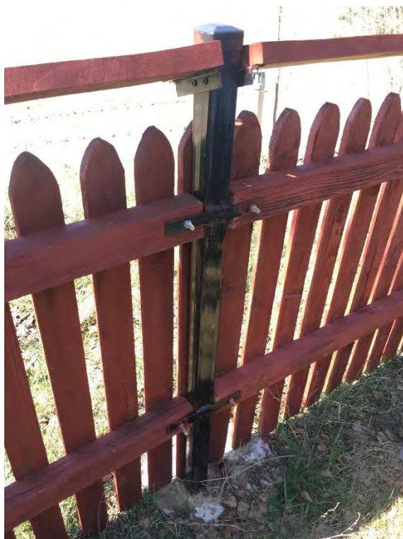
Właściwie przeprowadzony remont ogrodzenia. Przykład oczyszczenia i ponownego montażu przęsła do nowych słupków. - Osada Florianka 107 -
