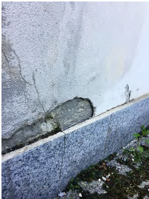
Fot. 13 Uszkodzenie tynku przy cokole budynku
