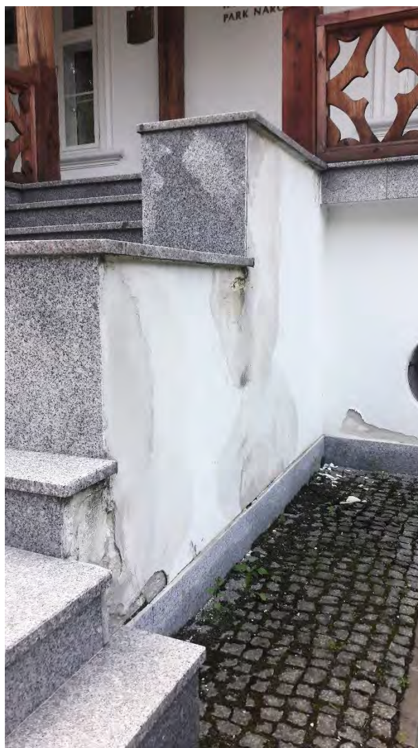
Fot. 8 Uszkodzenie tynku przy schodach wejściowych
