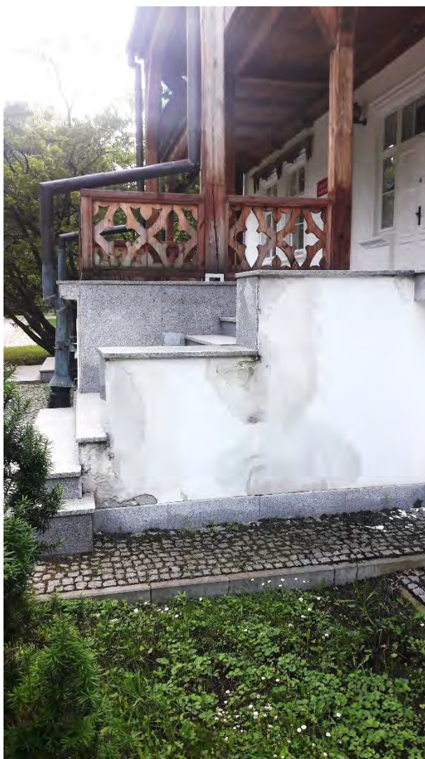
Fot. 7 Uszkodzenie tynku przy schodach wejściowych
