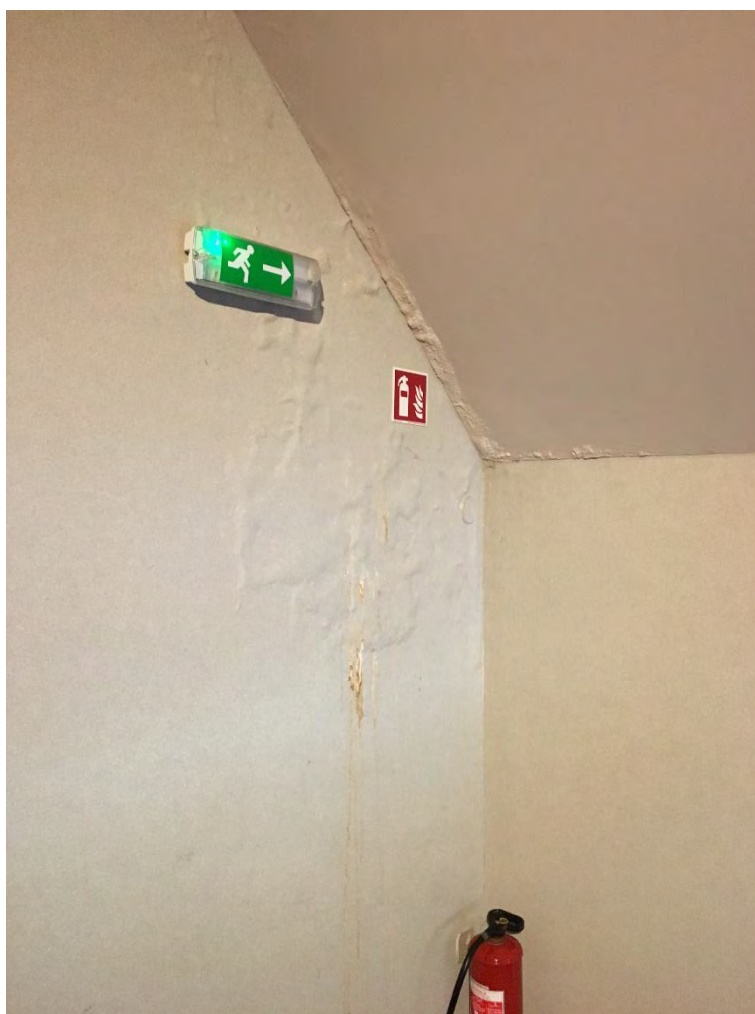
Remont tynku na klatce schodowej. - Ośrodek Edukacyjno-Muzealny – ul. Piłzowa 3 -
