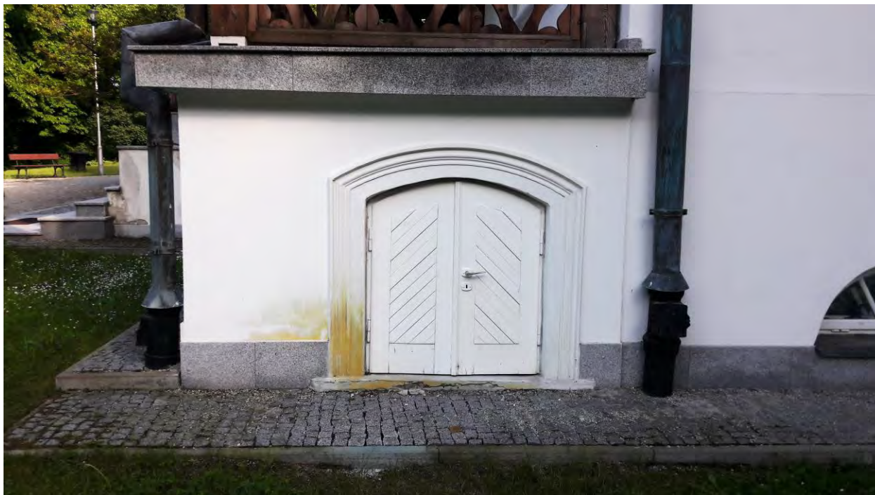
Fot. 9 Uszkodzenie tynku przy cokole budynku
