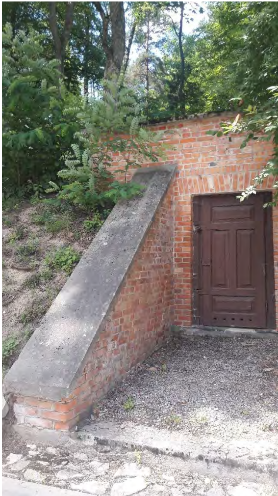
Fot. 3 Mur oporowy przy wejściu do lodowni
