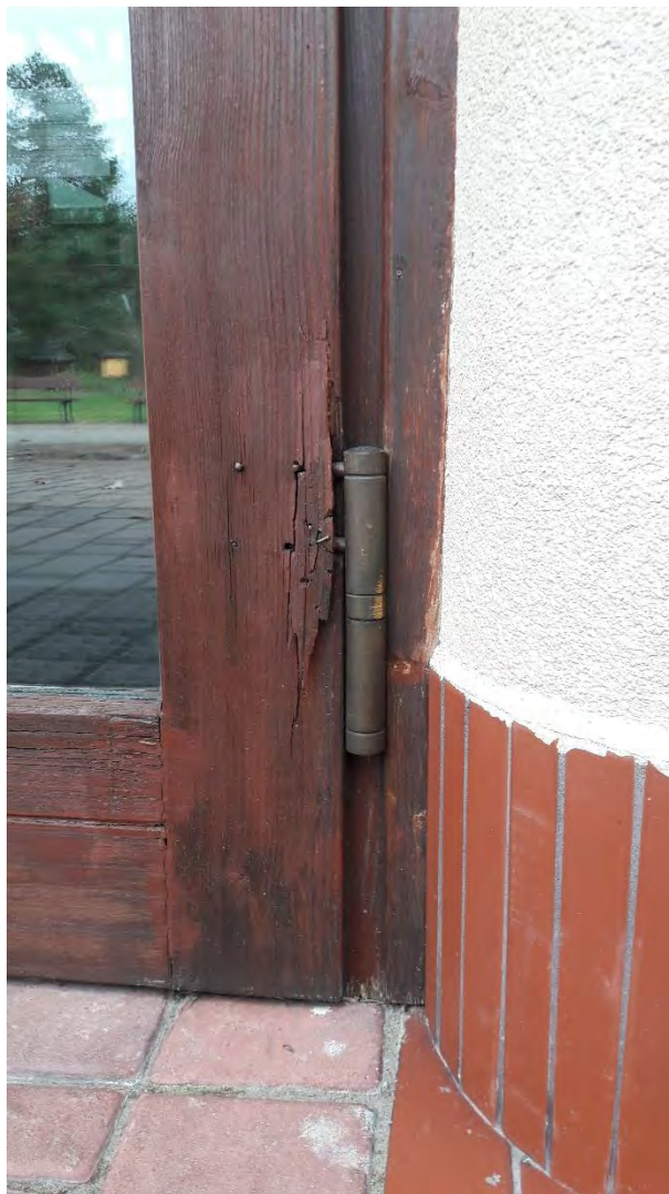
Remont mocowania zawiasu w drzwiach zewnętrznych. - Ośrodek Edukacyjno-Muzealny – ul. Plażowa 3 -
