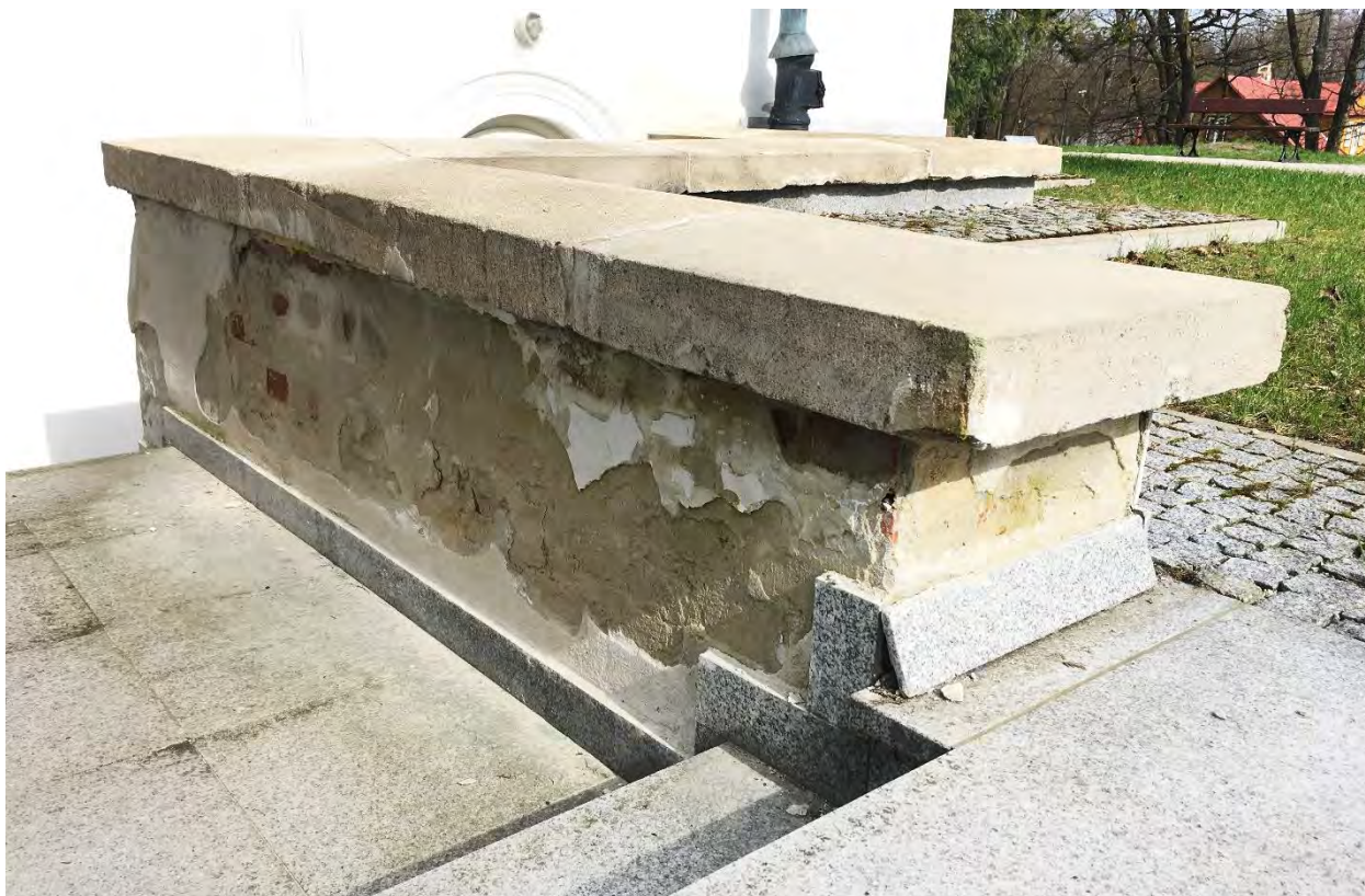
Fot. 15 Uszkodzenia muru oporowego przy schodach do piwnicy
