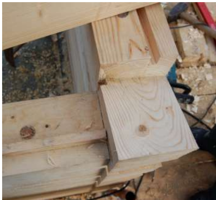
DYBLOWANIE SUMIKÓW, BALE PIÓRO-WPUST, OBRÓBKA WĘGŁA W JASKÓŁCZY OGON Z KRÓTKIM OSTATKIEM
