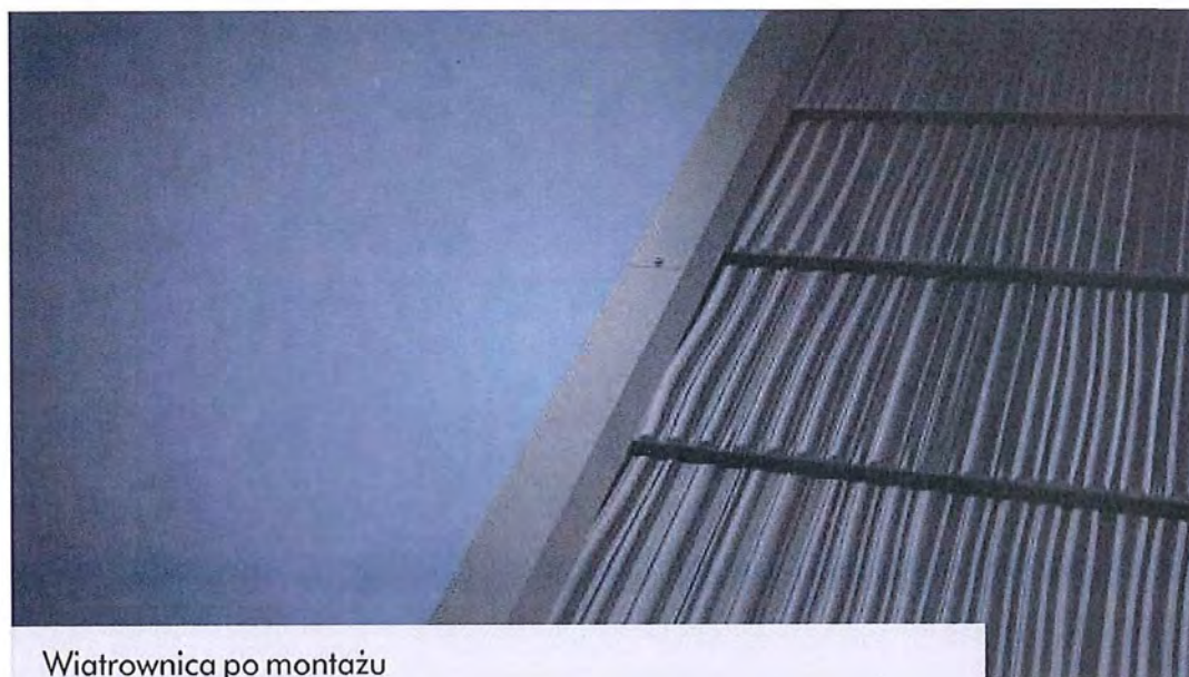
Panele od strony wiatrownicy należy podgiąć w taki sposób, aby stworzyły zakładkę uniemożliwiającą przedostawanie się wody i zanieczyszczeń pod wiatrownicę.
